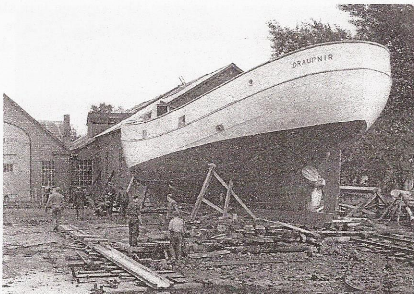
Her er islandskutteren ved at blive trukket sidelæns på vej over til sliken, hvorfra den skal søsættes.
