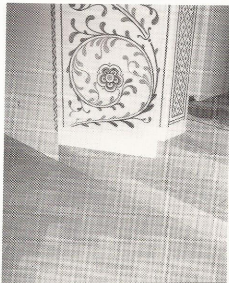
Der lægges nyt teglstengulv i stedet for kokos- tæppet.
